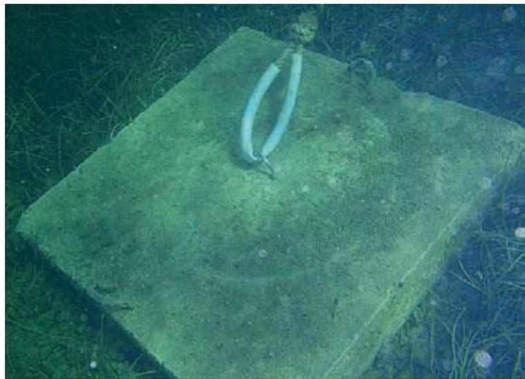
denn das obige Beispiel gilt ja nur bei einem gleichschenkeligen Dreieck. Ist beispielsweise die Verbindungsleine doppelt so lang wie die Wassertiefe, so reduziert dies die Vertikalkraft am Betonblock auf etwa ein Drittel der auf die Yacht einwirkenden Horizontalkraft. Bei un-
